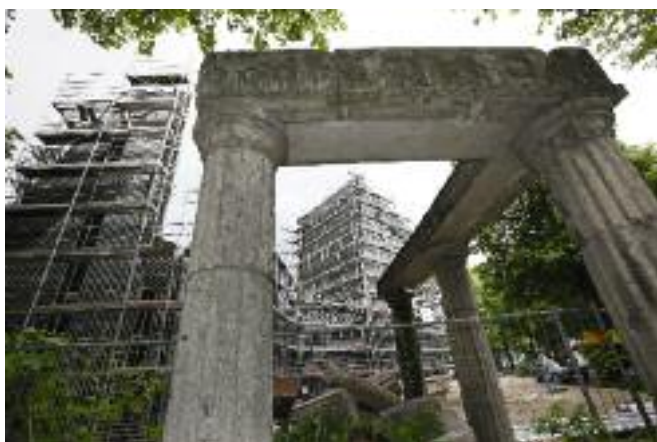
Gebäude im Entstehen © Sascha Kopp
